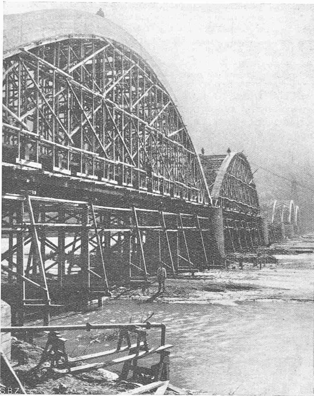
Abb. 7. Lehrgerüste zweier Hauptöffnungen.
