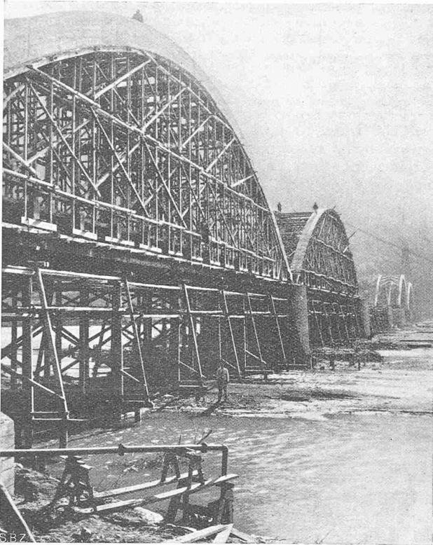
Abb. 7. Lehrgerüste zweier Hauptöffnungen.
