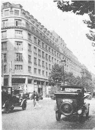
Abb. 7. Neues Geschäftshaus am Boulevard Haussmann in Paris.
