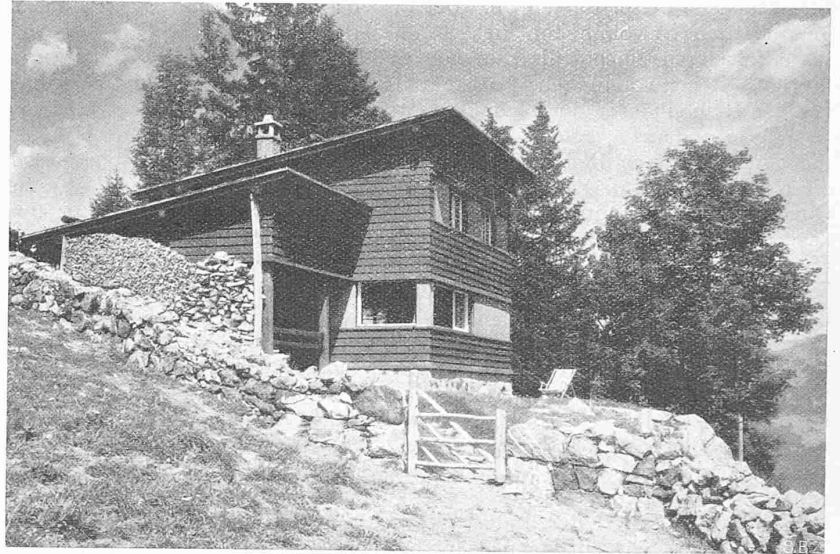
Abb. 5. Ansicht von Süd-Südwesten, im Sommer.
