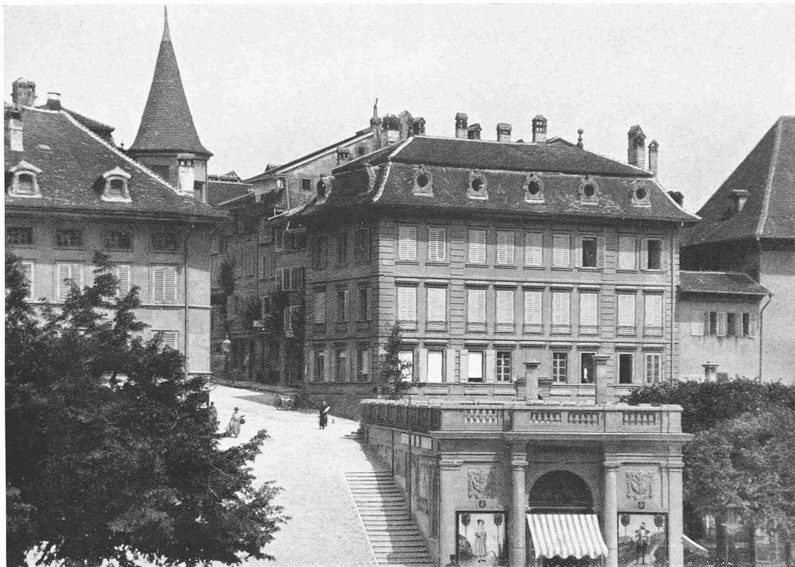
FRIBOURG, MAISON DE GENDRE, Nr. 181 RUE DE LA PRÉFECTURE
