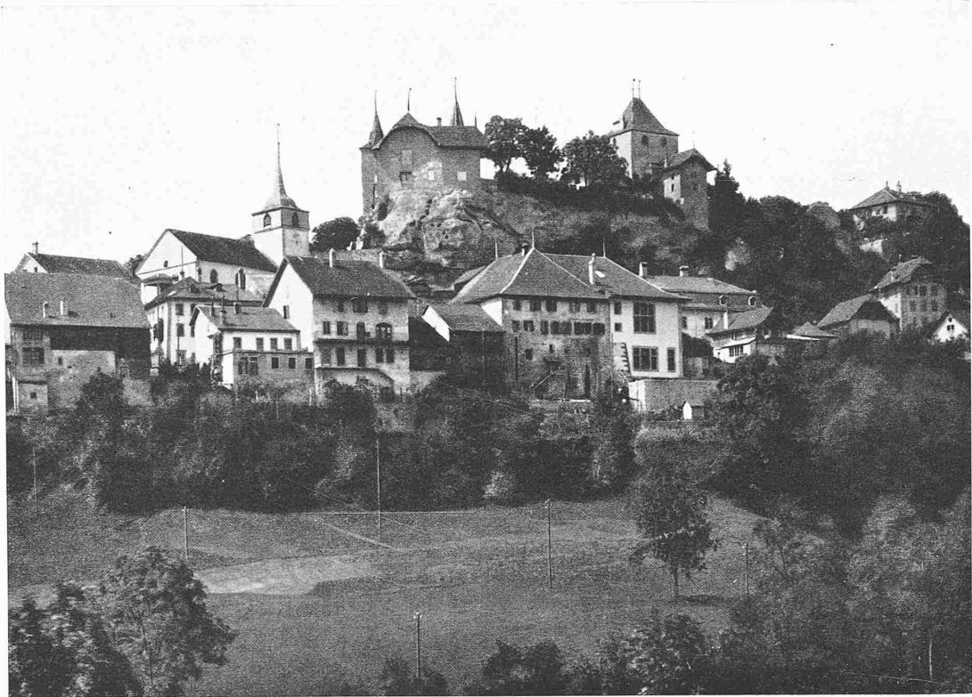
LA VILLE DE RUE, VUE GÉNÉRALE DU COTÉ EST
