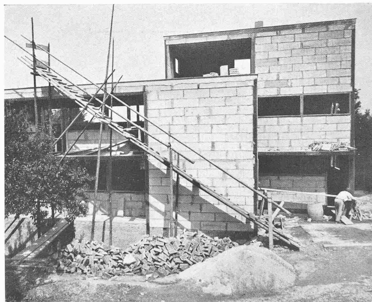
SÜDFRONT, IM BAU UND NACH VOLLENDUNG
