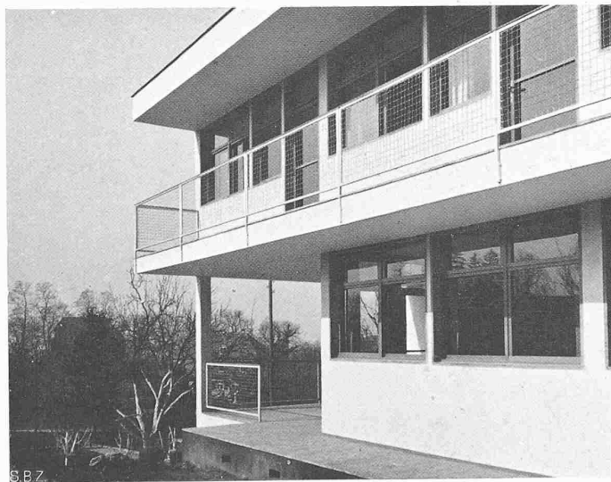
WOHNHAUS AN DER WENKENHALDE ARCHITEKTEN PAUL ARTARIA & HANS SCHMIDT, BASEL
