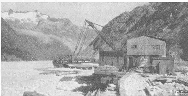
Abb. 2. Kiesbaggerung auf dem Aareboden, Blick gegen NO.
