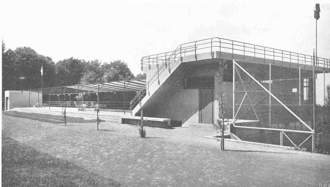
Abb. 3. TERRASSENBAU AUS NORDEN, VOM FUSSBALLPLATZ AUS SPORTPLATZANLAGE SONNENBERG AM ZÜRICHBERG ARCHITEKTEN v. TETMAJER, DEBRUNNER & BLANKART, ZÜRICH UND LUZERN
