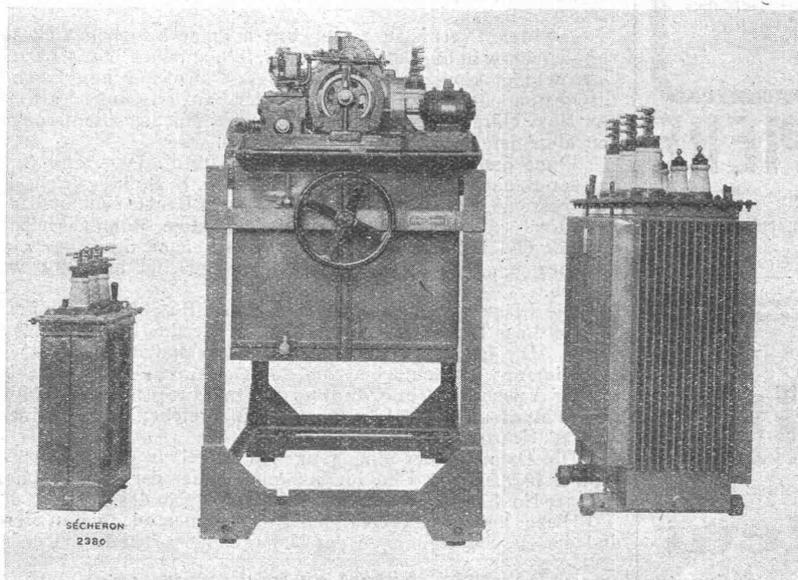
Réglage automatique d'un feeder triphasé 1500 kVA,  $8000 \pm 10\%$  V, 50 pér.
