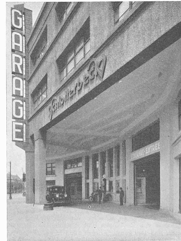
Abb. 2. Unterfahrt und Tankstelle, Ein- und Ausfahrt.
