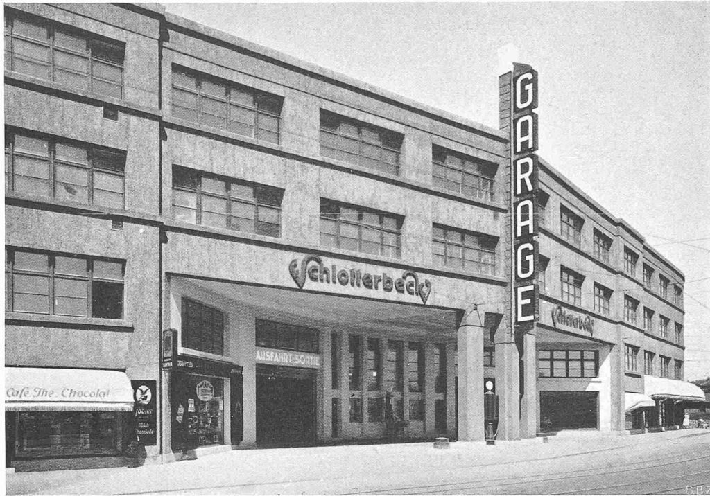
Abb. 7. BLICK GEGEN AUSFAHRT UND EINFAHRT
