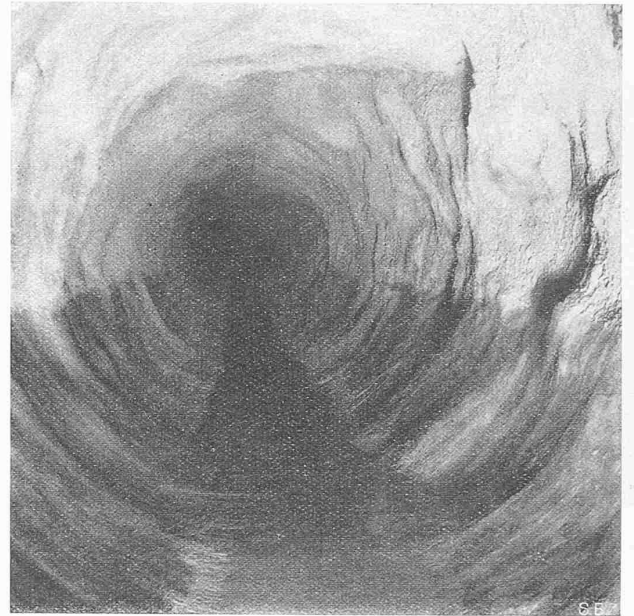
Abb. 25. Gunitierte unausgemauerte Stollenstrecke (Okt. 1922).
