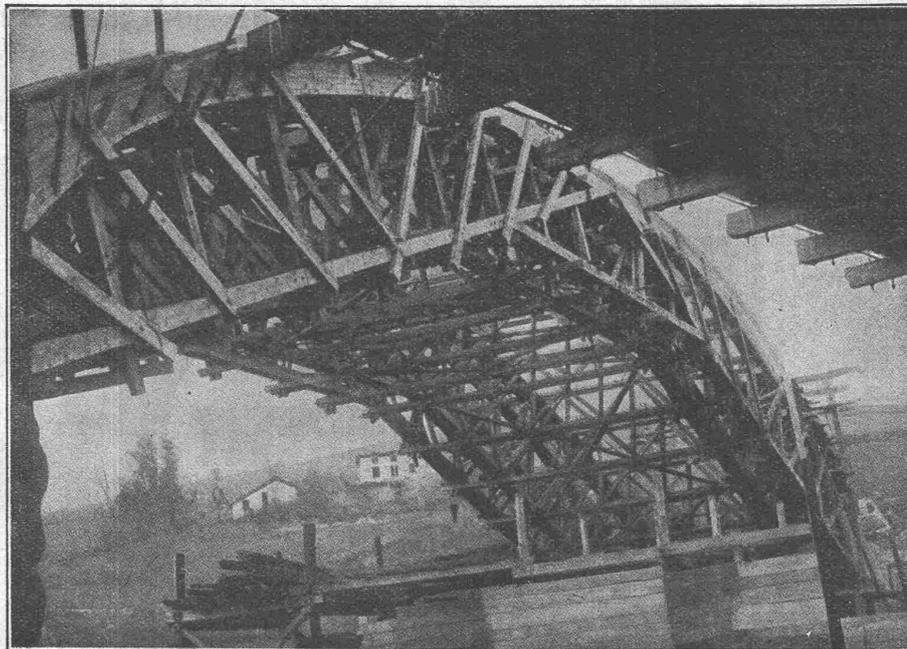
Lehrgerüst Pont d' Itxassou - 69,00 m Spannweite
