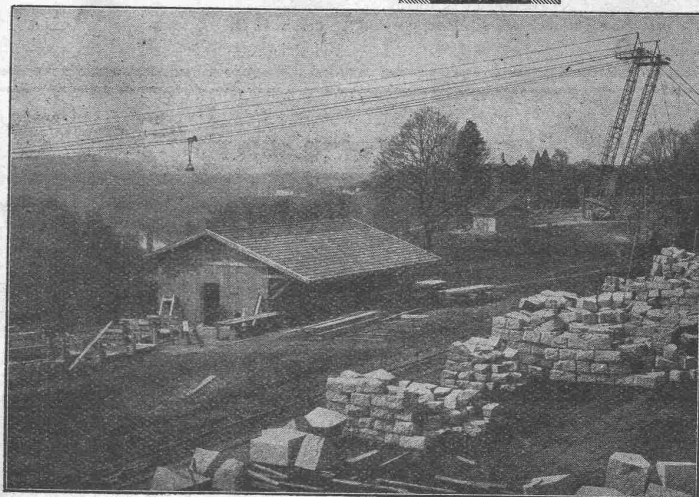
Zwei Mastenkabelkrane von 480 m Spannweite beim Bau der Rhônebrücke.
