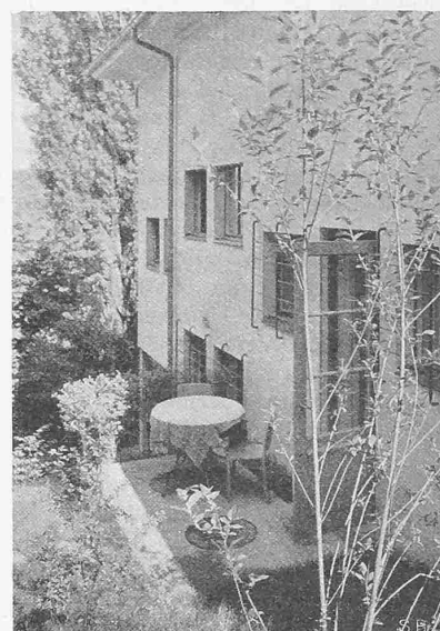
Abb. 5. Nebeneingang an der Rückseite.
