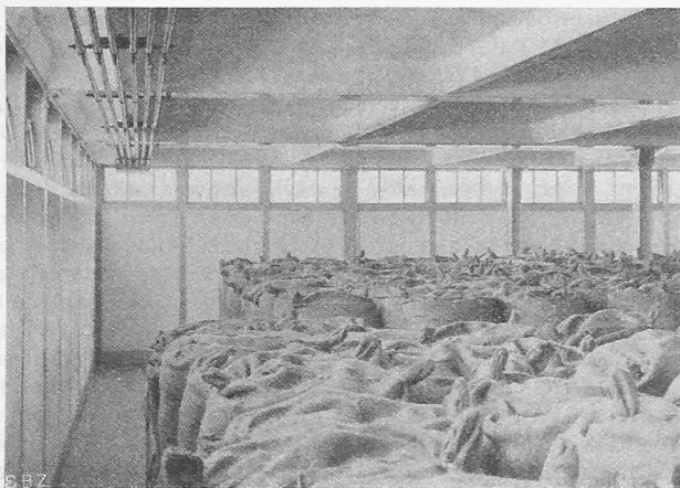
Abb. 5. Lagerraum, Aussenwände unverkleidet, Linearheizung an der Decke.
