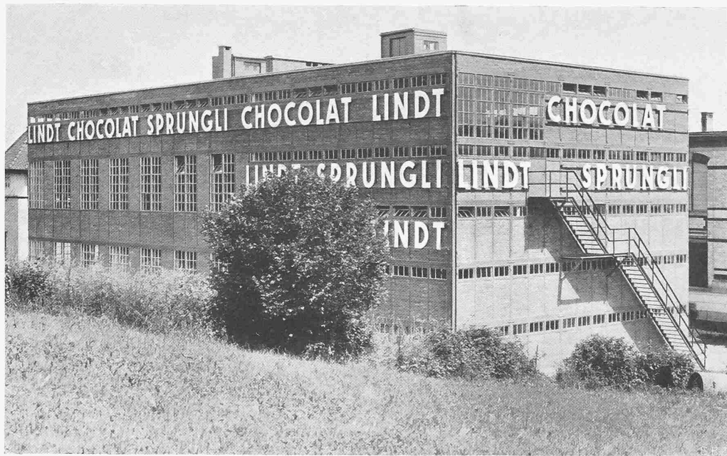
CACAO-LAGERHAUS UND -ROESTEREI IN KILCHBERG BEI ZÜRICH EISENSKELETTBAU VON W. KOCH & CIE., ZÜRICH AUSMAUERUNG IN ROTEM BACKSTEIN
