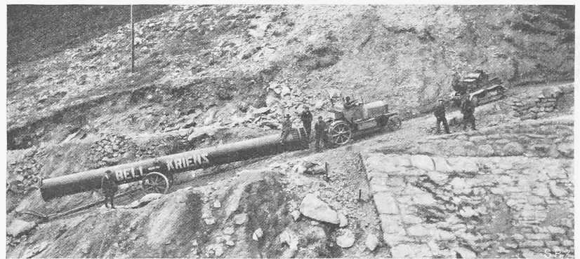
Abb. 78. Rohrtransport auf einer Steigung von 30%.
