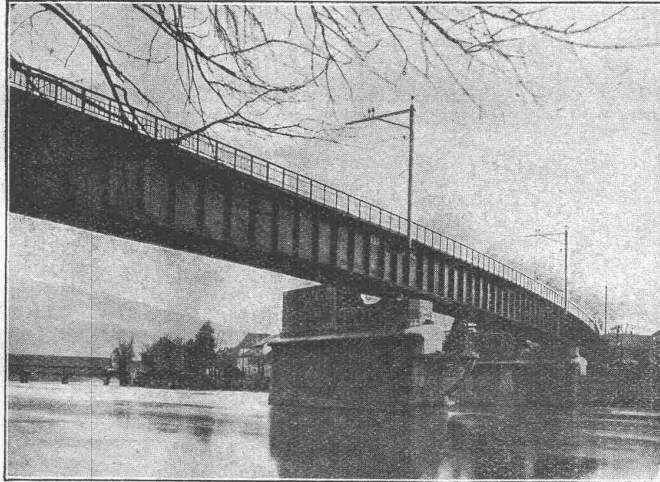
Neue Eisenbahnbrücke, sogenannte Gäubahnbrücke der S. B. B. über die Aare bei Olten. Erstellt 1927.
