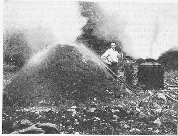
Abb. 4. Vergleichsversuche mit Meiler und tragbarem Ofen.
