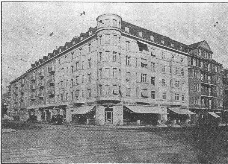
Geschäfts- und Wohnhäuser am Kreuzplatz in Zürich 7.
