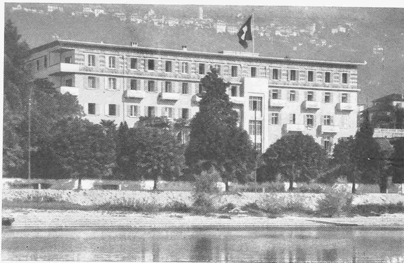
Abb 8. Um- und ausgebautes Hotel Reber in Locarno. Arch. A. Meili, Luzern.
