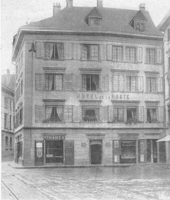
Abb. 1. Hotel Post in Luzern, alter Zustand.
