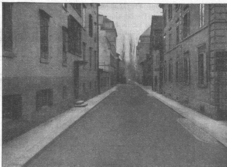
GLARNISCHSTRASSE ZÜRICH Walz-Asphalt: Topeka, 6 cm stark
