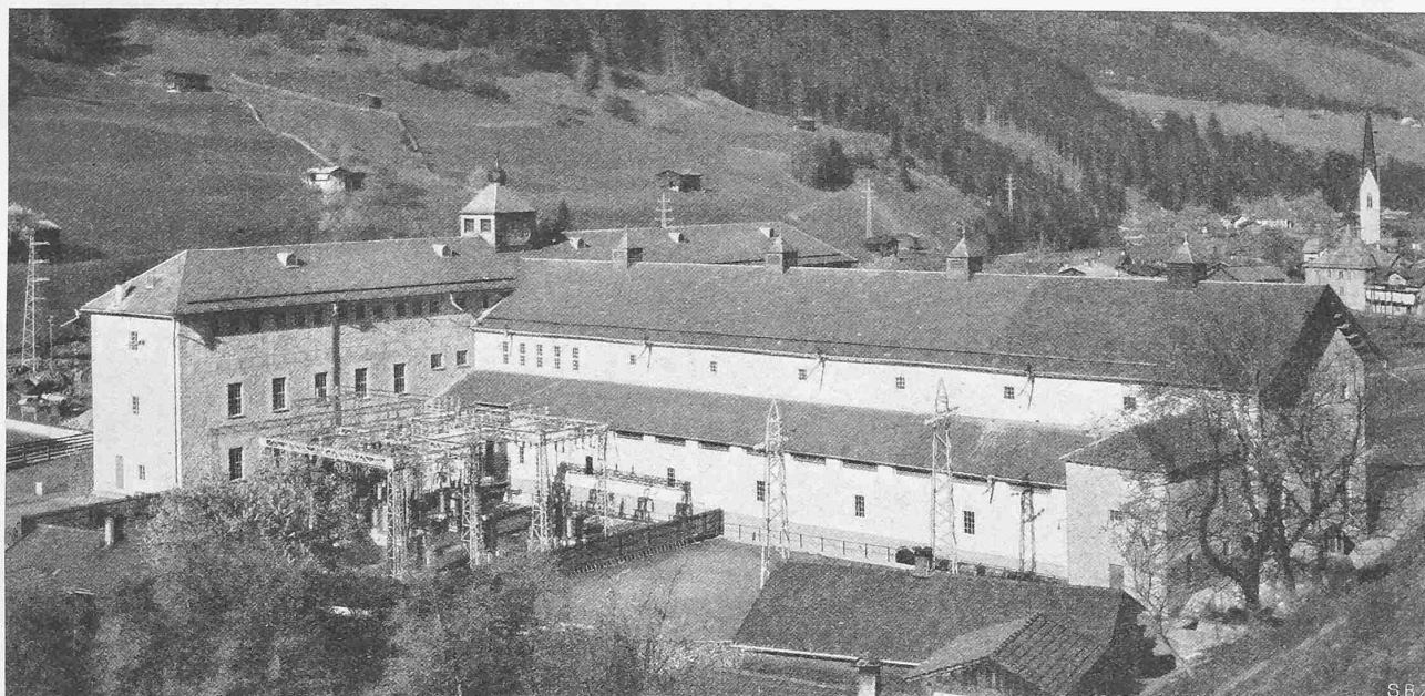
Abb. 81. Die Zentrale Küblis aus Osten, mit der 64 kV Freiluft-Schaltanlage für die Stromabgabe an die Schweizerischen Bundesbahnen.
