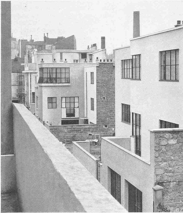
Abb. 9. Blick auf die Siedlung. Im Mittelgrund Haus Jean Lurçat.
