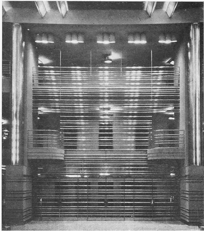
Abb. 6. Halle mit dem Leuchtgitter vor den Galerien zum Zuschauerraum.
