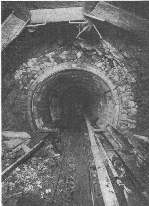
Stollenbau System „Bauschäfer“ der Zementwerke A. G. Häusen bei Brugg
