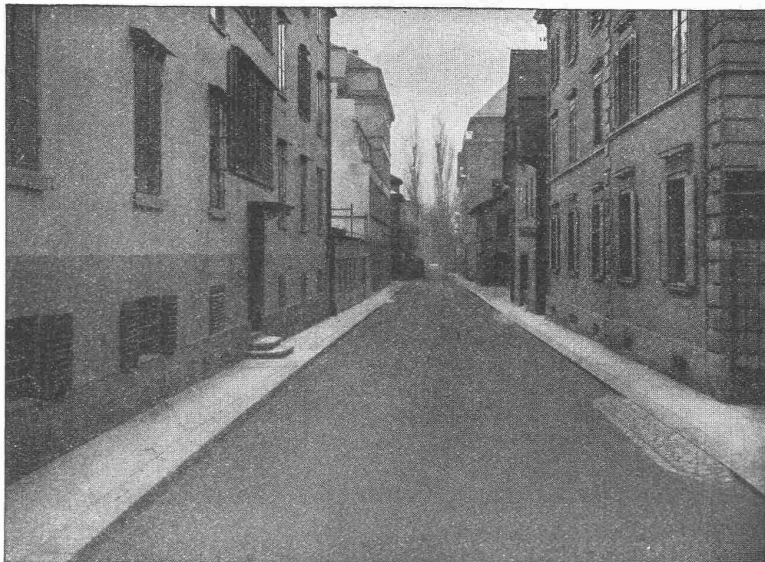
GLARNISCHSTRASSE ZÜRICH Walz-Asphalt: Topeka, 6 cm stark
