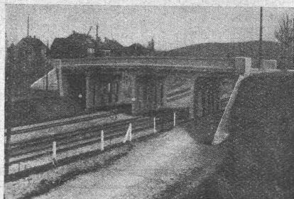
Römerstrassenbrücke in Winterthur
