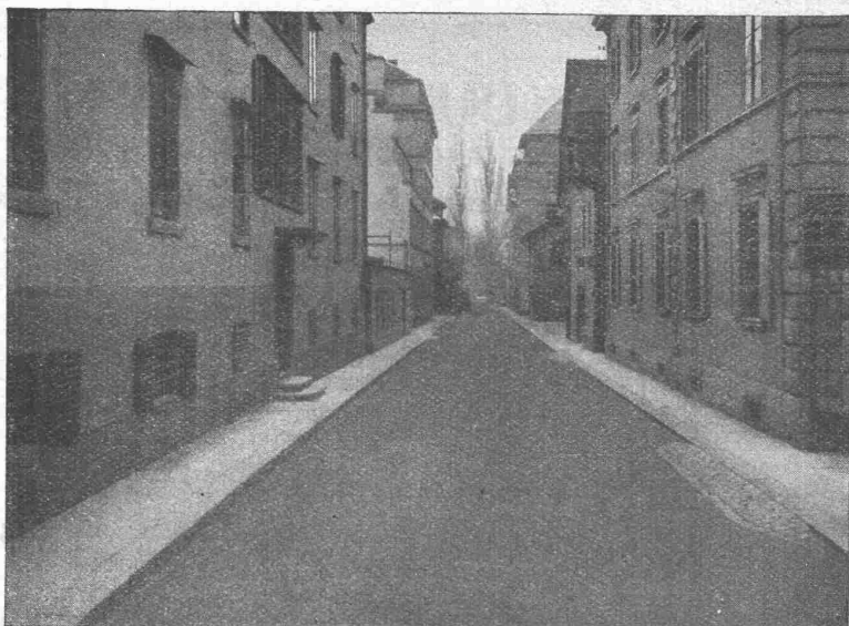
GLARNISCHSTRASSE ZÜRICH Walz-Asphalt: Topeka, 6 cm stark
