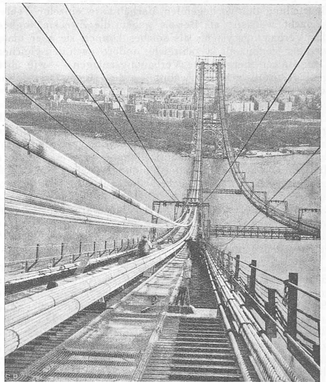
Abb. 30. Drahtstränge und Kabelmontage (26. November 1929).
