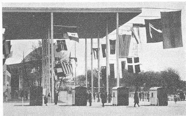
Abb. 2. Haupteingang mit Kassenhäuschen. Die eisernen Dachstützen sind verglast und nachts von innen beleuchtet.
