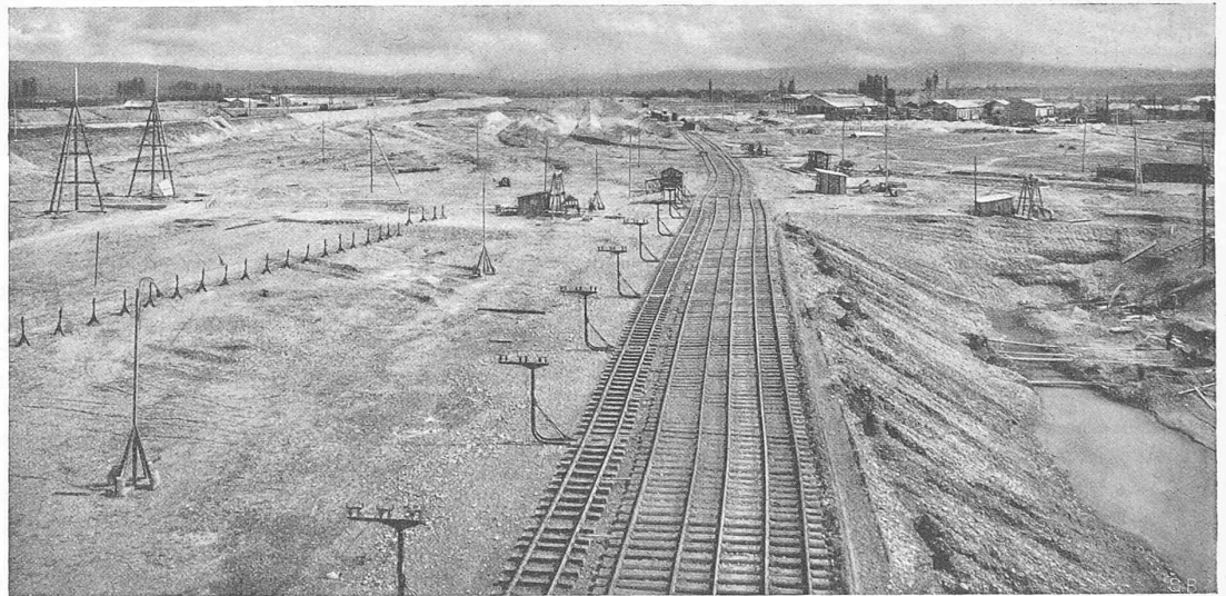
Abb. 11. Gleiseanlage für den Eimerkettenbagger und die zwei meterspurigen Bedienungsgleise.
