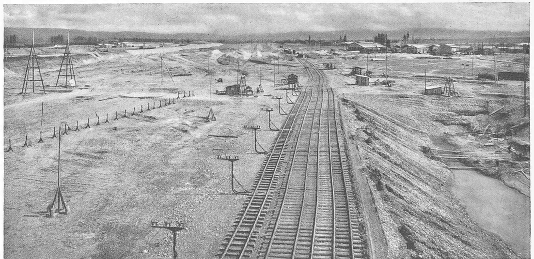
Abb. 11. Geleiseanlage für den Eimerkettenbagger und die zwei meterspurigen Bedienungseise.
