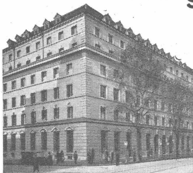
VOLKSBANK ZÜRICH, ARCHITEKTEN HONEGGER & MOSER, ZÜRICH
