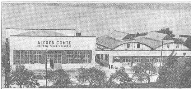
Flugzeugfabrik in Horgen 1700 m 2 Bitumitekt-Bedachungen grünschiefer-besandet
