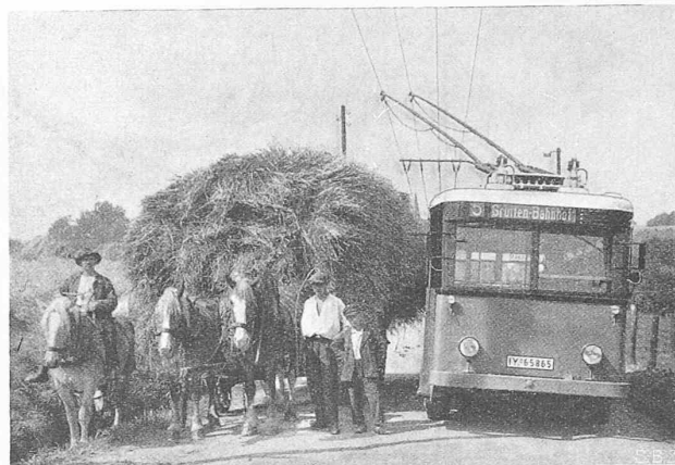
Abb. 1 und 2. Dreiachsiger elektrischer Omnibus mit Oberleitung für den Lokalverkehr Mettmann-Gruiten im Rheinland.
