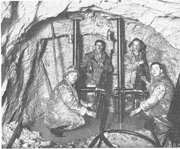
Abb. 4. „Ingersoll-Rand“-Bohrhämmer auf Spannsäulen.
