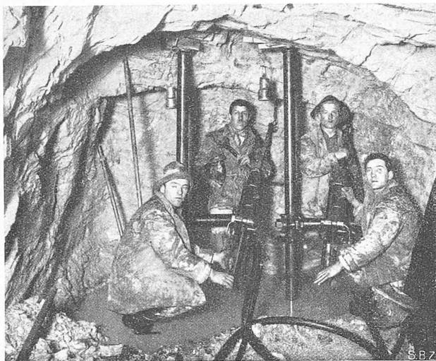
Abb. 4. „Ingersoll-Rand“-Bohrhämmer auf Spannsäulen.
