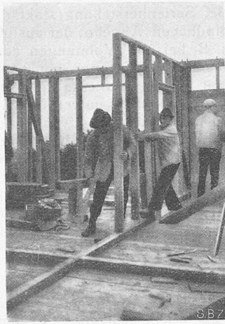
Abb. 5. Aufstellen der Wandrahmen.
