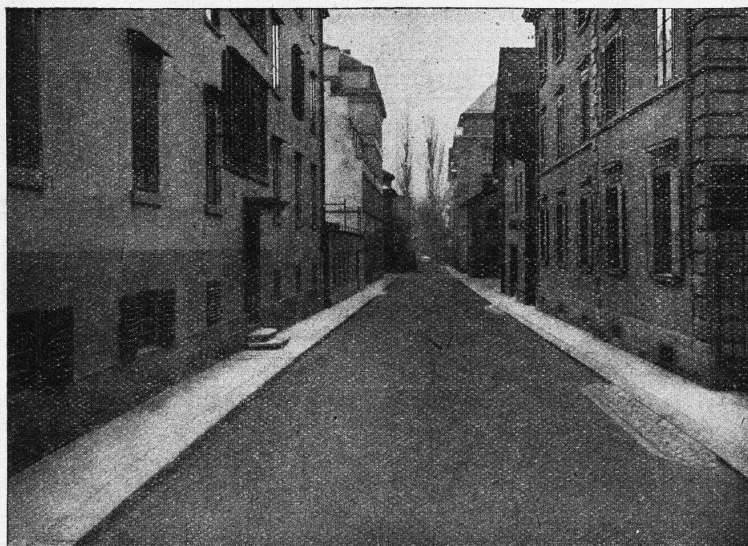
GLARNISCHSTRASSE ZÜRICH Walz-Asphalt: Topeka, 6 cm stark
