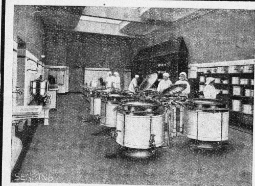
Senking-Ideal-Kochkessel und Kippöpfe aus nichtrostendem Stahl V2a. Innenkessel mit dem oberen Profilring nahtlos aus einem Stück hergestellt. Vollkommen hygienisch
