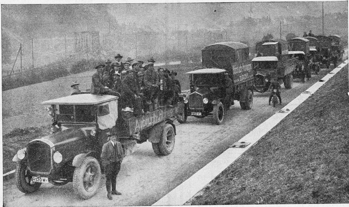
Sieben BERN A Kipper der aus zwölf BERN A bestehenden Kolonne für Abbrucharbeiten.
