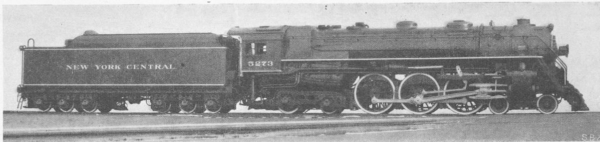
Abb. 8. Heissdampf-Schnellzuglokomotive Typ 2C2 der New York Central Railway. — Gesamtradstand mit Tender 25,5 m, max. Zugkraft 19 200 kg.
