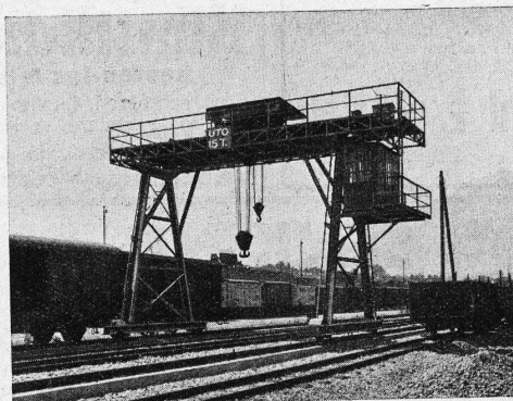
Fahrbarer Bockkran mit zwei Hubwerken
