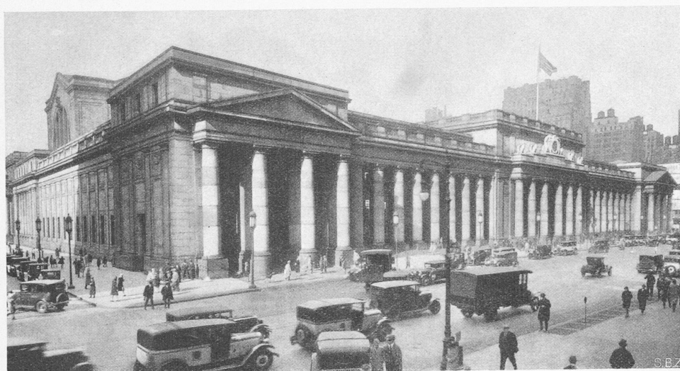
Abb. 13. Untergrund-Bahnhof der Pennsylvaniabahn in New York City.
