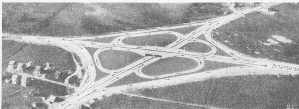
Abb. 42. Kreuzung zweier Hauptstrassen mit Ueberführungsbauwerk.
