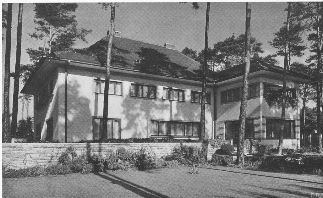
WOHNHAUS DR. B. IN BERLIN-DAHLEM ARCHITEKT PROF. O. R. SALVISBERG, BERLIN UND ZÜRICH
