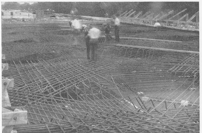
Abb. 57. Bewehrung der Pilzdecken zum Viadukt in Abb. 54 und 55.
