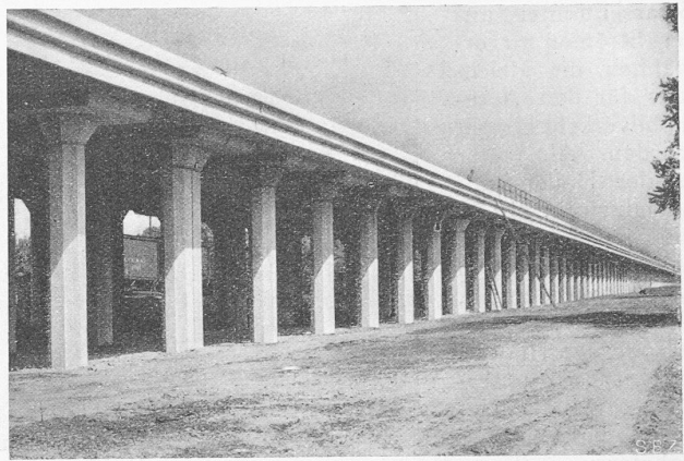
Abb. 54 und 55. Viergleisiger Viadukt in amerikanischer Pilzdeckenform für die Bahnhof-Erweiterung in Columbus (Ohio) der Pennsylvania R. R.
