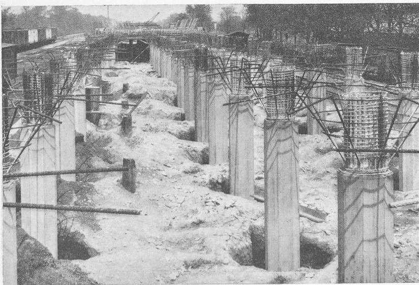
Abb. 56. Säulen- und Pilzköpfen-Bewehrung zum Viadukt in Abb. 54 und 55.
