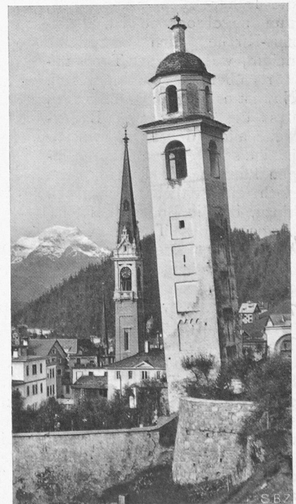
Abb. 2. Alter und neuer Turm aus Nordosten.
