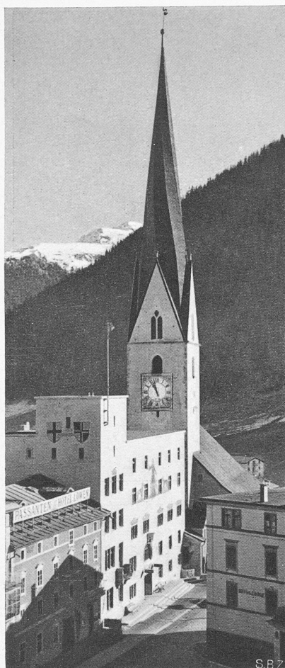
Abb. 1. Der Turm zu St. Johann, erbaut 1481. Der Helm ist durch klimatische Einflüsse gedreht.
