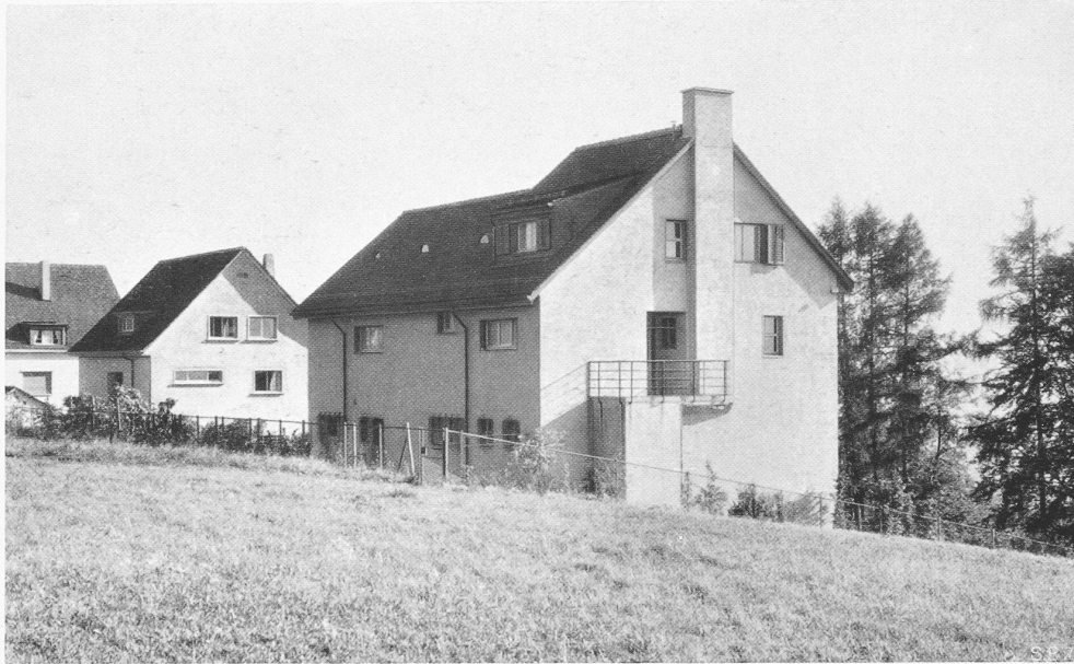
WOHNHAUS ARCH. EGIDIUS STREIFF, AM MAIENBURGWEG, ZÜRICH AUS NORDEN GESEHEN; LINKS DAS HAUS DEUSS
