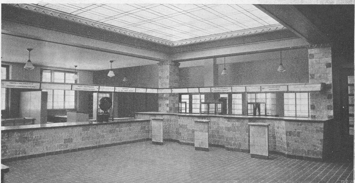
Abb. 5. Schalterhalle des Postgebäudes in Biel. — Kunstkeramik, Lausener Bodenklinker, Holz gebeizt. Entwurf und Bauleitung Direktion der Eidg. Bauten, Bern.
