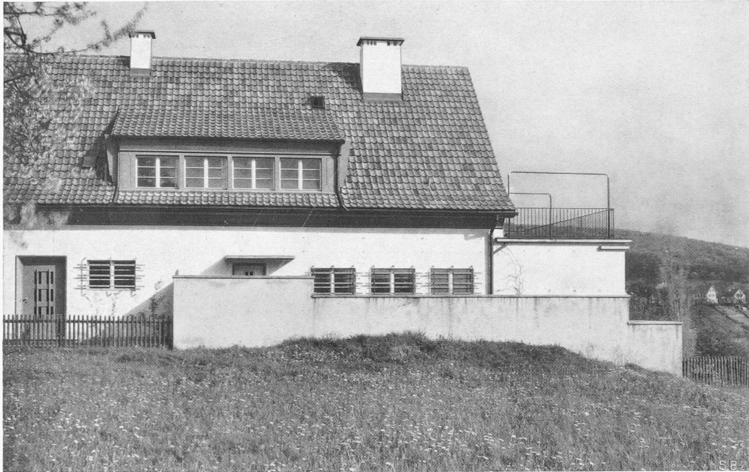
WOHNHAUS L. IN RIEHEN, NORDÖSTLICH BASELS ARCH. RUD. CHRIST, BASEL
