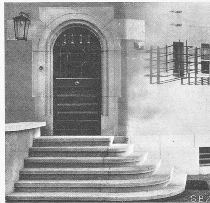
Abb. 20. Hauseingang, Lautengartenstrasse Nr. 2.
