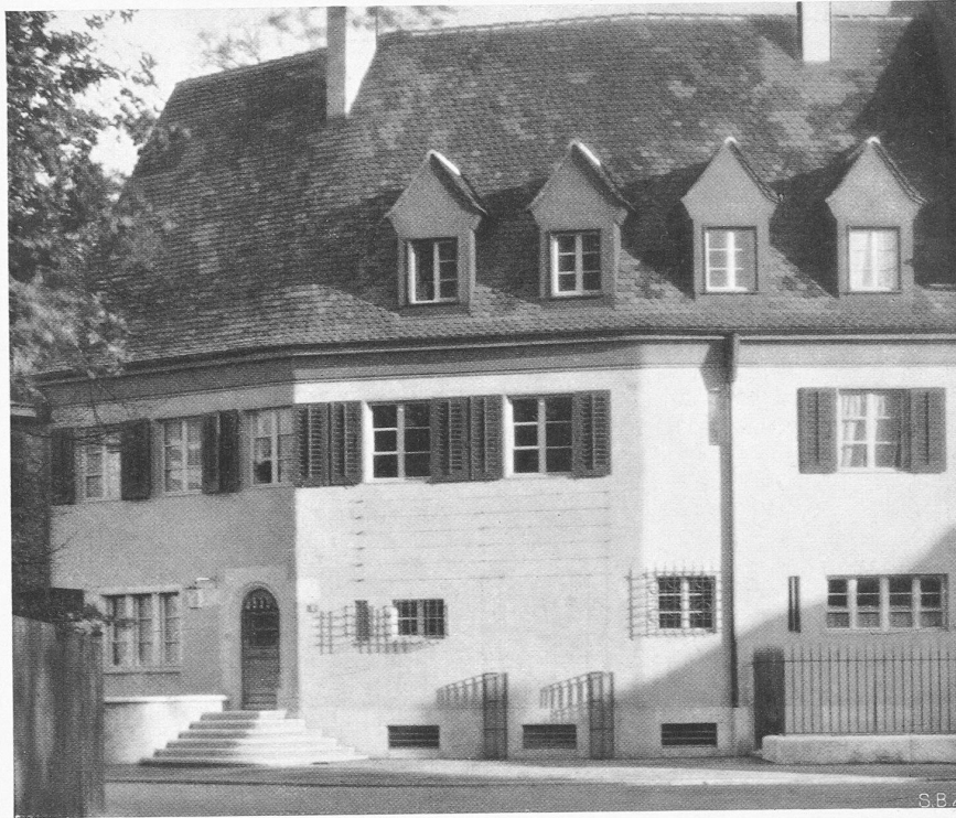
WOHNHAUS AM DUFOURPLATZ IN BASEL ARCH. RUD. CHRIST, BASEL
