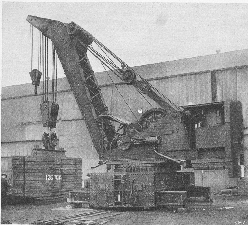
Abb. 2. Der 105 t Kran bei der Prüfung mit einer Ueberlast von 126 t bei 6,1 m Ausladung. Die Gegengewichte sind unter dem Maschinistenstand angehängt.
